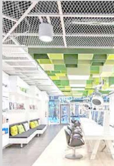
Apesar de não serem estruturalmente necessários, os forros têm sido cada vez mais utilizados na arquitetura brasileira. Funcionando como uma parte importante do acabamento, o material pode facilitar e esconder a passagem das instalações e auxiliar no conforto térmico e acústico. Muitos materiais estão disponíveis no mercado – gesso, pvc, madeira, etc - e a escolha pode depender de vários fatores como custo, conforto, manutenção, durabilidade e é claro, estética.
