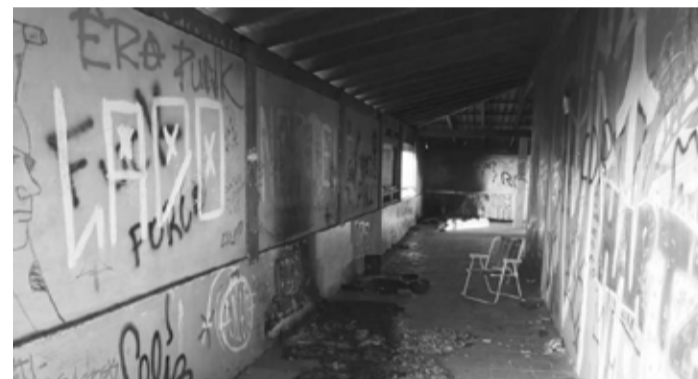
Paredes pichadas e sujeira marcam o imóvel abandonado
