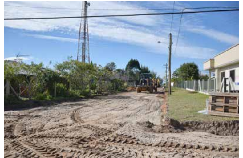
Rua Caxias do Sul, no Balneário Atlântico, irá receber pavimentação em PAVS
