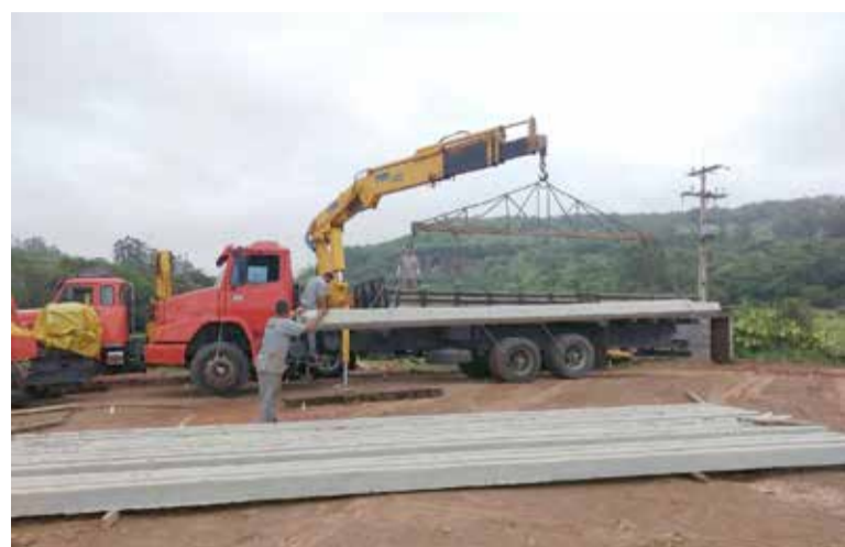
Fundações da nova EMEI já foram feitas
