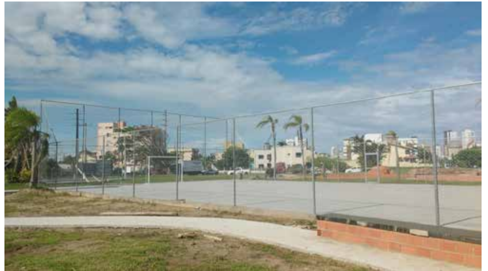
Praça atualmente está em fase final de obras
