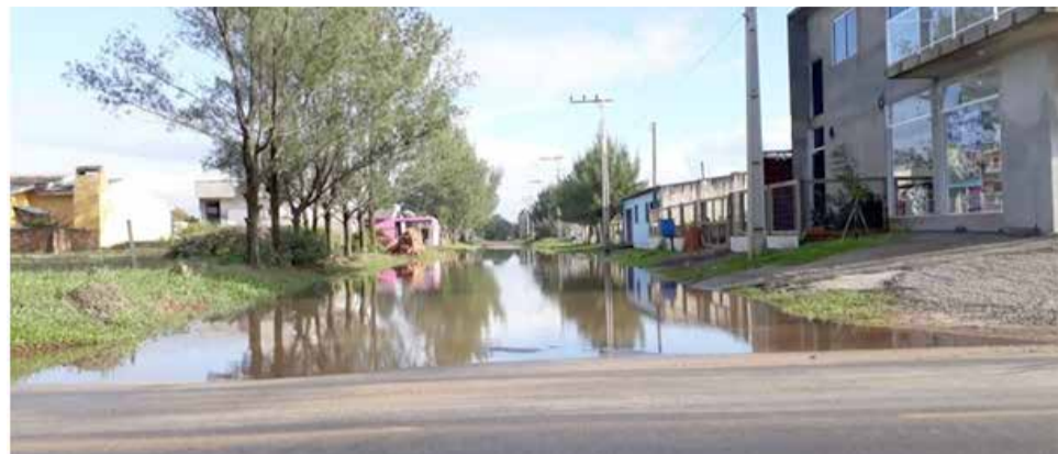
Uma das várias vias do Passo de Torres que ficaram alagadas recentemente
