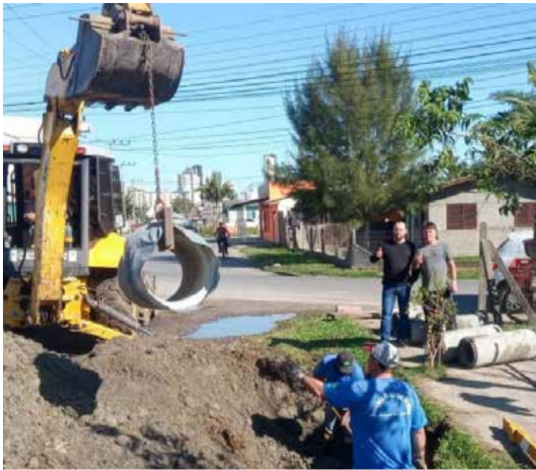
Prefeito Jonas Souza acompanhando obra de drenagem
