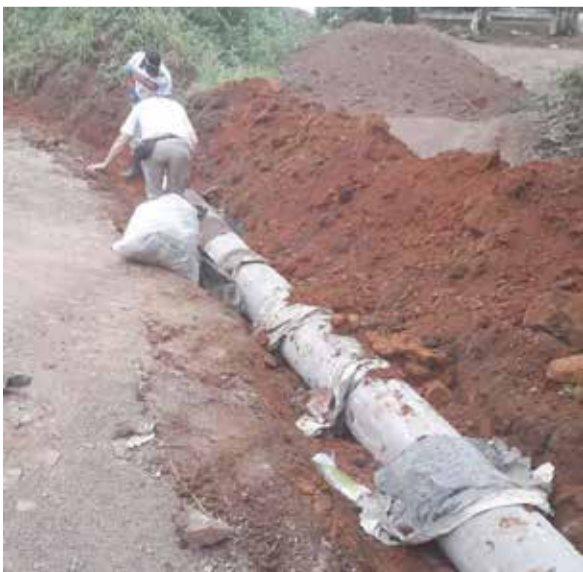
Instalação de bueiro no Morro dos Passarinhos
