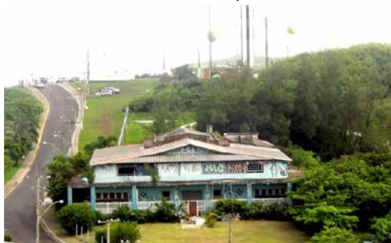
Prédio da antiga Escola Cenecista, no Morro do Farol
