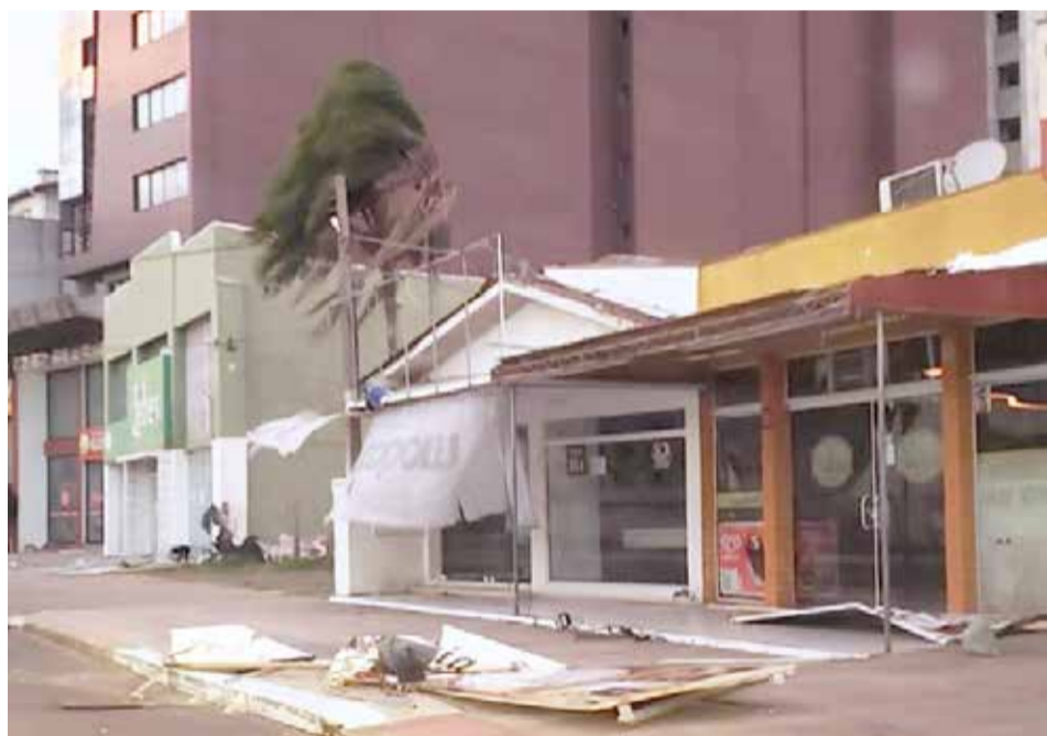
Danos registrados também em estabelecimentos do Centro de Torres
