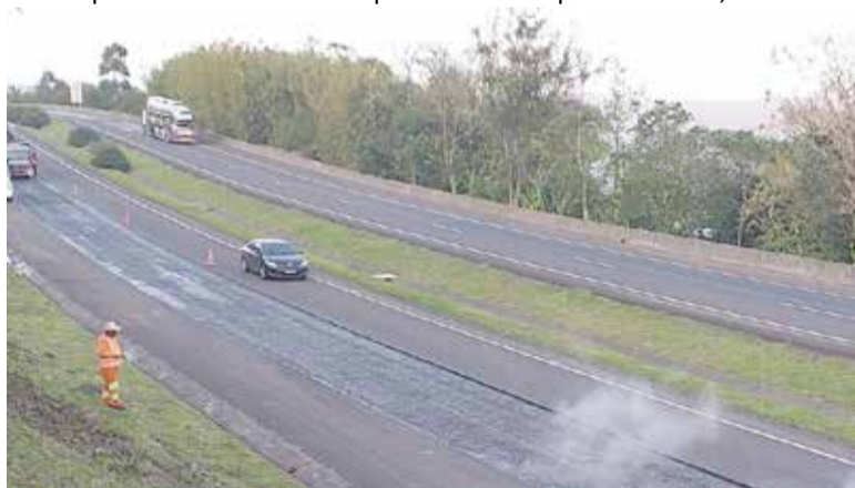
Trabalhos na BR-101
