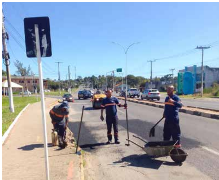
Operação Tapa-Buracos da Prefeitura iniciando pela Av. Castelo Branco
