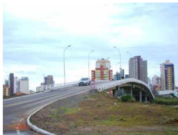
Próximo à ponte (foto) existe uma estrutura antiga em Torres, onde moradores de rua se alojam com seus cães recentemente
