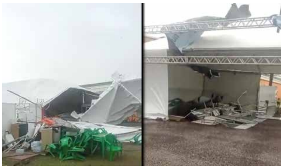
Estragos em centro de eventos de Tramandaí
