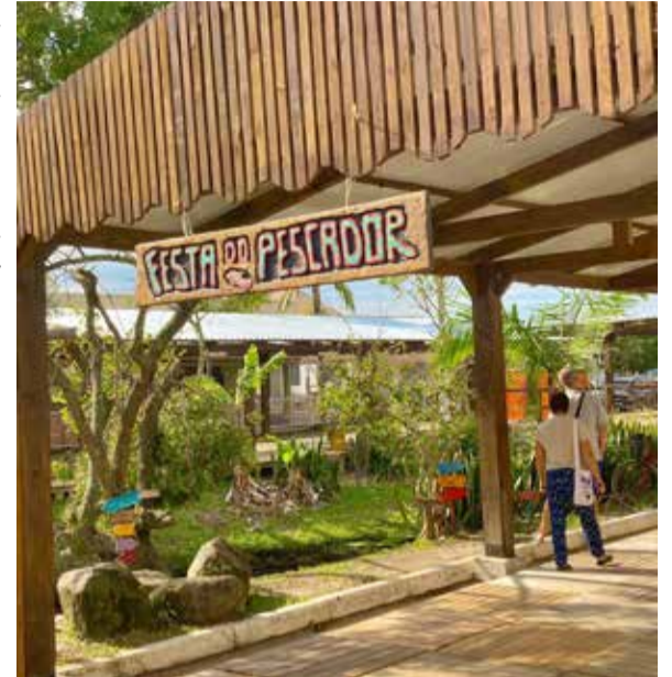
Nova cobertura coberta do Calçadão do Artesão
