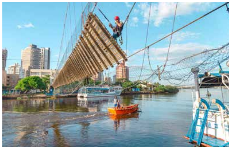
Ponte que desabou no Rio Mampituba em fevereiro deve ser reinaugurada antes do Natal. (Foto: Prefeitura de Passo de Torres / Divulgação)
