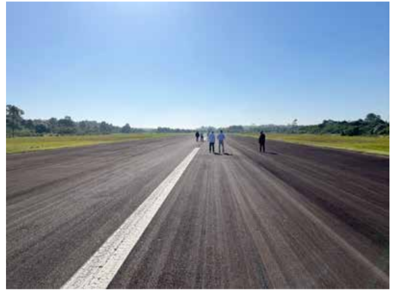
Pista do Aeroporto de Torres
