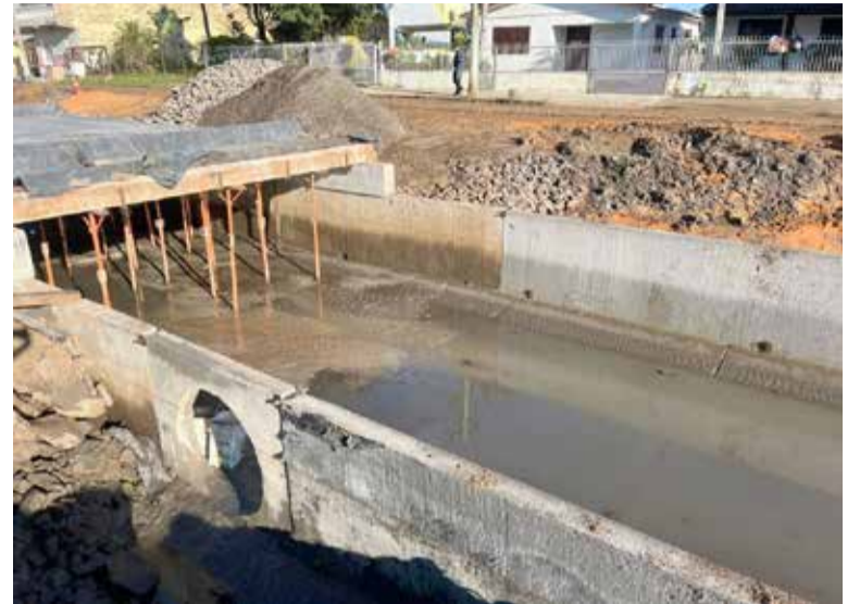
Imagem meramente ilustrativa das obras recentes na Av. do Riacho
