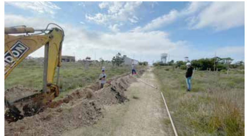
Avenida que serve de ligação para interpraias está recebendo encanamentos
