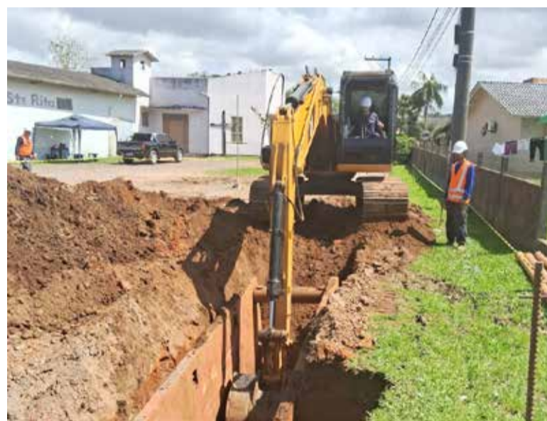
Implantação de redes de esgoto no bairro São Jorge
