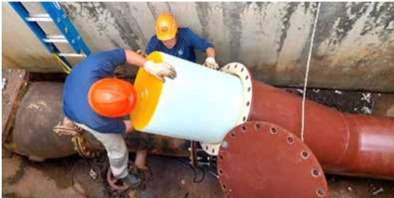
A Corsan concluiu, na terça-feira, 19, a limpeza da tubulação de 10 mil metros que leva água do rio Cornélias, na divisa entre Capão da Canoa e Terra de Areia, para a estação de tratamento em Curumim. Os técnicos utilizaram o método PIG (Projectile Injected Gas), com a introdução de uma bucha dentro da canalização, que vai raspando e removendo resíduos que se acumulam nas pare-
