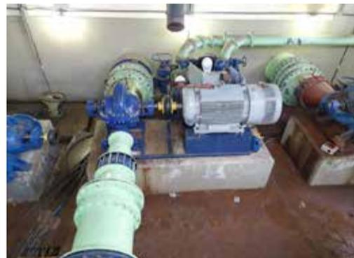
abastecimento de Torres, a Corsan instalou uma nova bomba na estação de tratamento de água. O equipamento compõe o conjunto de motor-bomba e vai garantir maior volume de armazenamento nos reservatórios.
