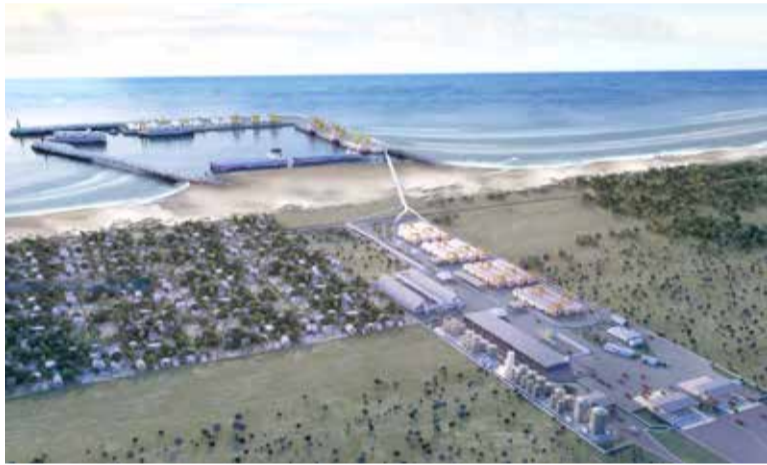
Maquete eletrônica esboça como ficaria projeto do Porto Meridional em Arroio do Sal (por DTA ENGENHARIA/DIVULGAÇÃO)
