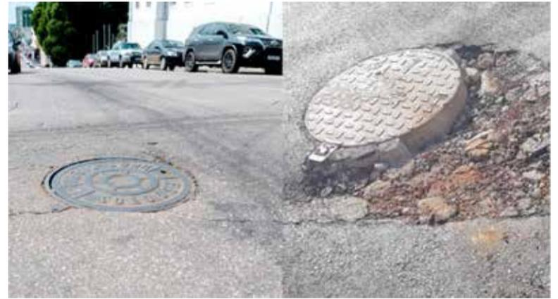
**Imagem meramente ilustrativas de um bueiro esburacado (d) e outro parafuso (e)**
