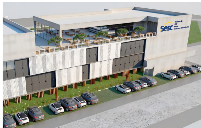
Prédio comercial está sendo construído em frente ao Hotel Sesc Torres, na Rua Plínio Kroef, 465
