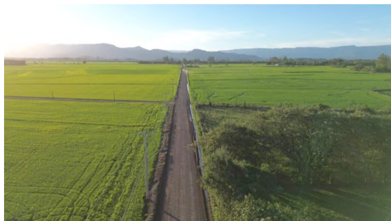
Trecho da RS-453 – via que interliga Torres à cidade de Mampituba
