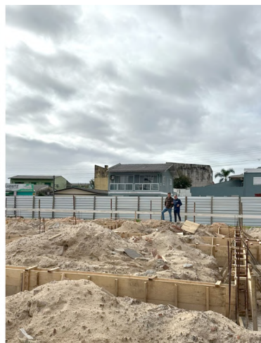
Obras na EMEI João XXIII
