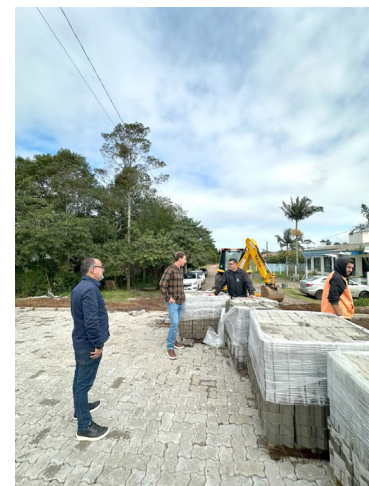
Pavimentação na Rua Horácio Russo
