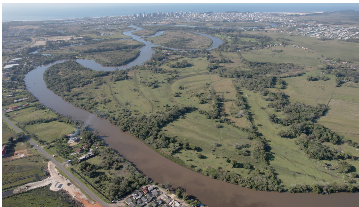
Área onde está prevista a incorporação do novo empreendimento
